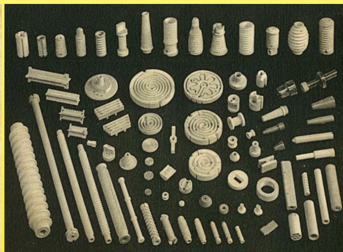
1938 год. Изоляционные детали из стеатита для электротермии (каталог 1938 г. La Steatite industrielle, музей Ultimheat)
